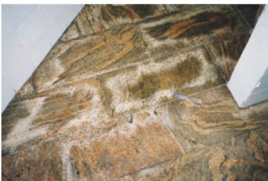
Foto 95 - Exemplo de piso em granito, com patologia de escamação superficial causada por umidade ascendente.
