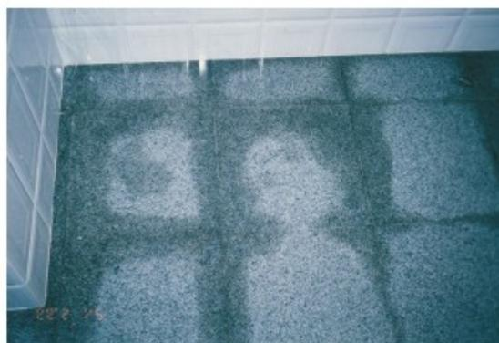
Foto 52 - Escurecimento por umidade em granito, nas adjacências das juntas.
