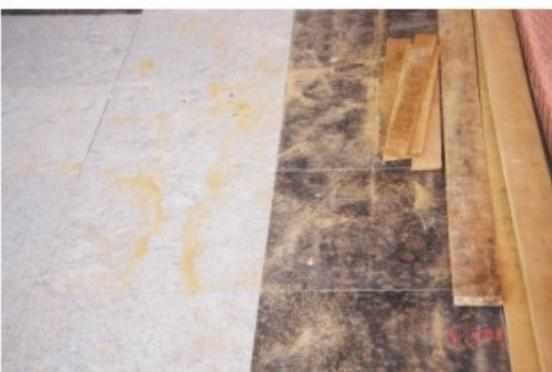
Foto 107 - Restos de madeira e pó de madeira sobre piso de granito (risco de manchamento após contato com água).
