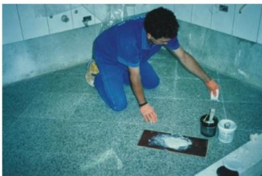
Foto 79 - Aplicação de rejuntamento de base epóxi (bicomponente).
