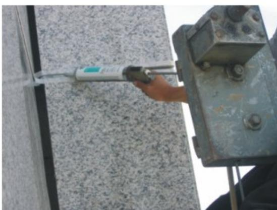
Foto 94 - Detalhe da foto 97, com aplicação de silicone em juntas de fachada.
