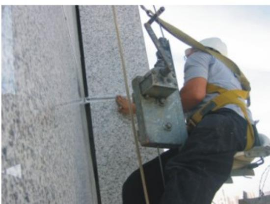
Foto 93 - Aplicação de rejuntamento de silicone em juntas de fachada aerada/ventilada.
