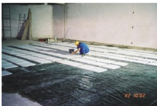
Foto 96 - Utilização de produto impermeabilizante no tardo das placas rochosas, para aplicação de piso em área sujeita à umidade ascendente.
