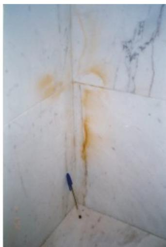
Foto 68 - Detalhe de piso e parede manchados devido à presença de impurezas na areia da argamassa de fixação.
