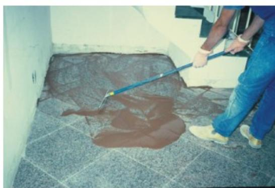
Foto 78- Aplicação de rejuntamento à base de calda de cimento.
