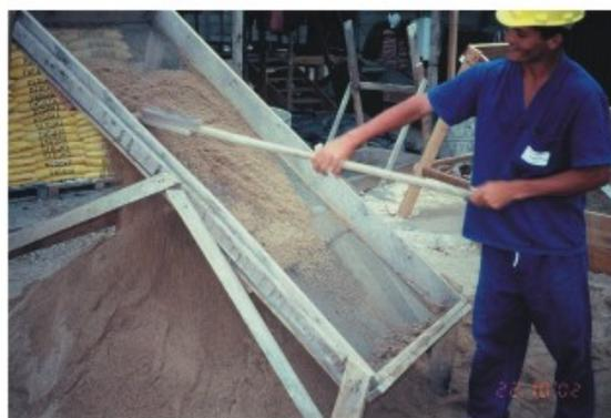
Foto 66 - Peneiramento de areia previamente lavada, para remoção de impurezas (seixos, torrões de argila, fragmentos de madeira, etc.)
