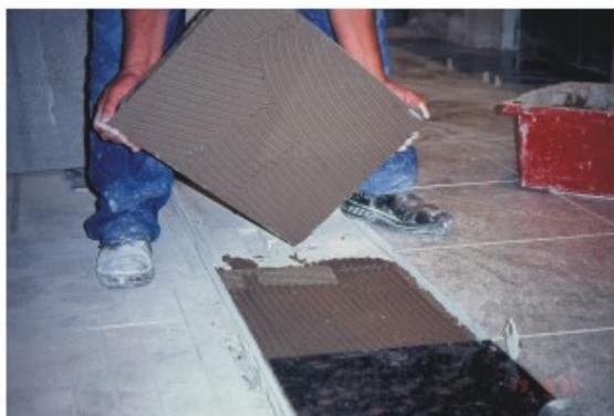
Foto 75 - Aplicação de argamassa colante no tardoço da placa de rocha e no contrapiso, processo de dupla camada.
